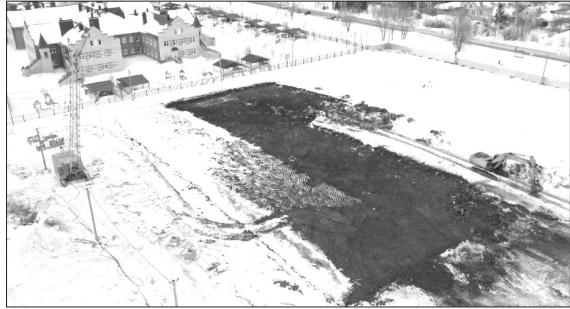
Строительство школы на улице Мурманской в городе Бузулуке уже началось.
