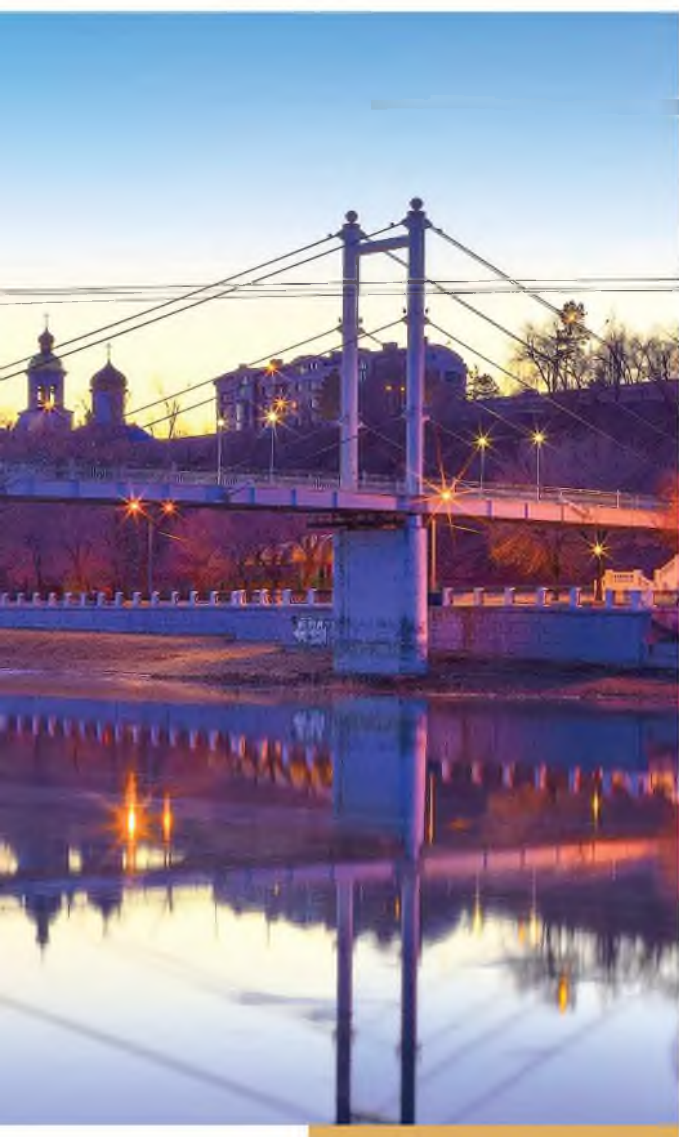
Пешеходный мост через реку Урал. Оренбург
